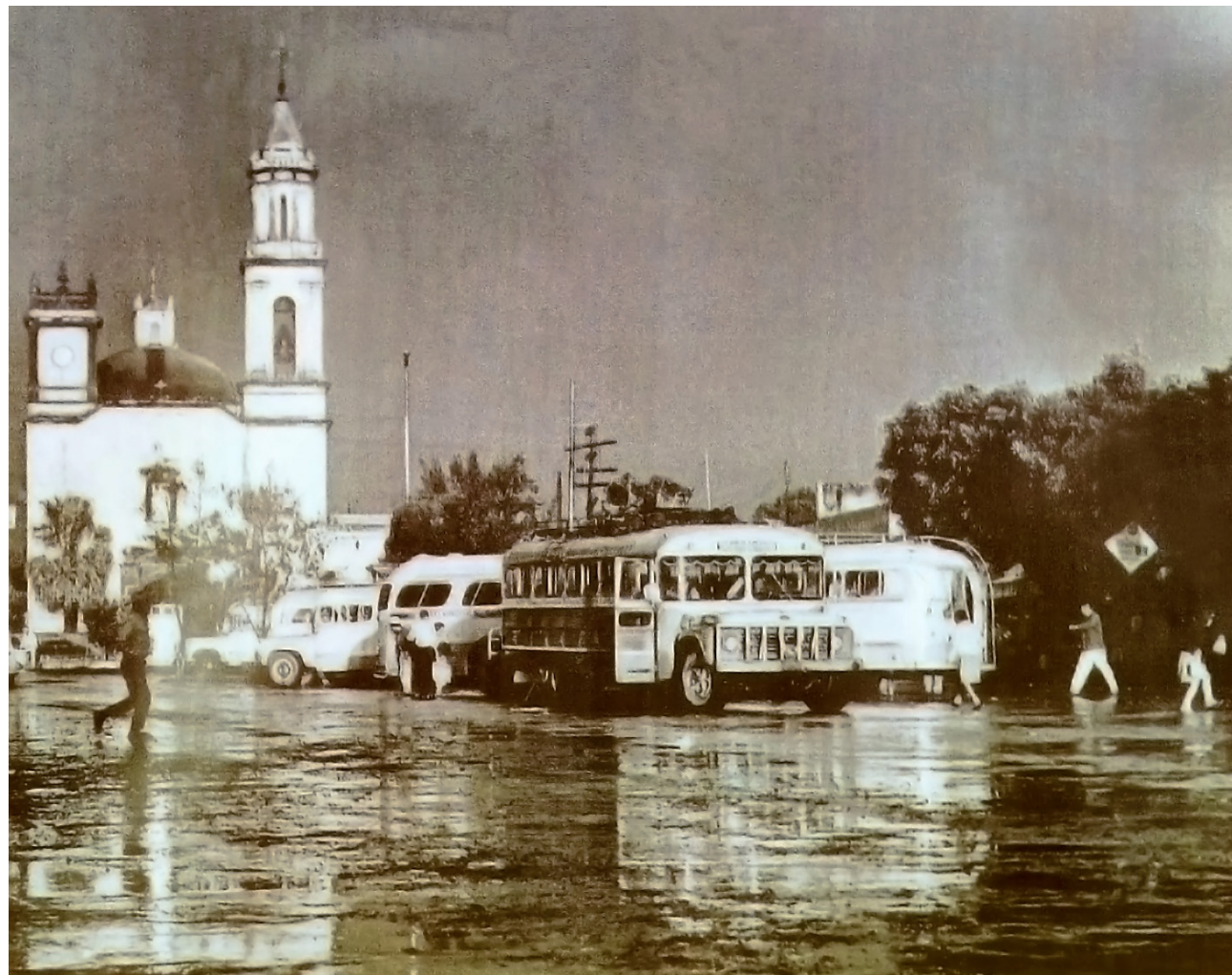
Antigua central de autobuses.
