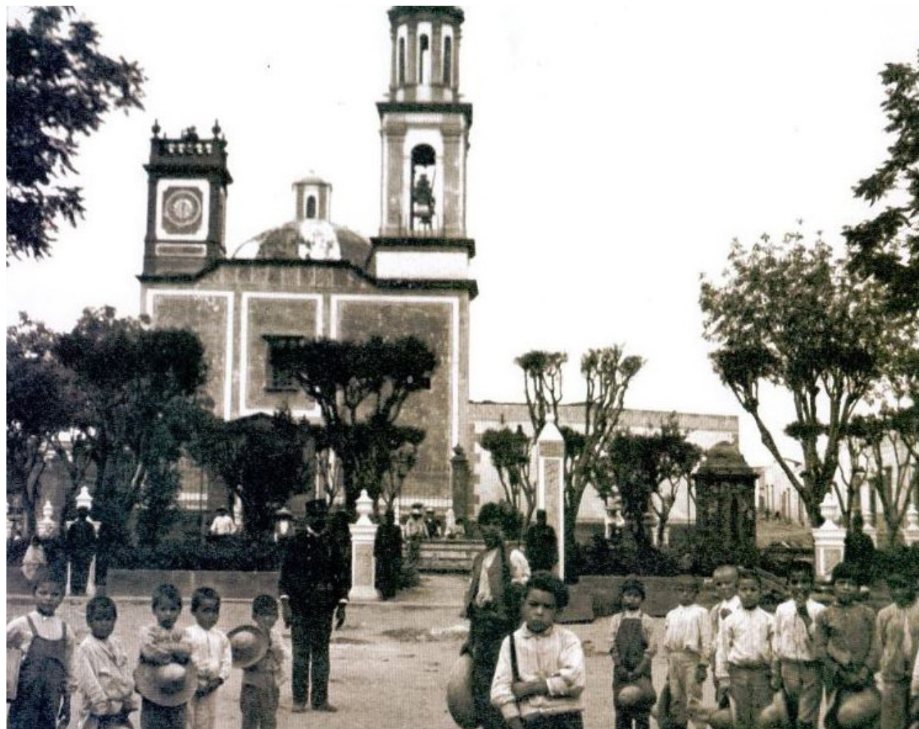
Plazuela del Sacromonte, al fondo, la caja de agua que surtía a la ciudad, 1930.
