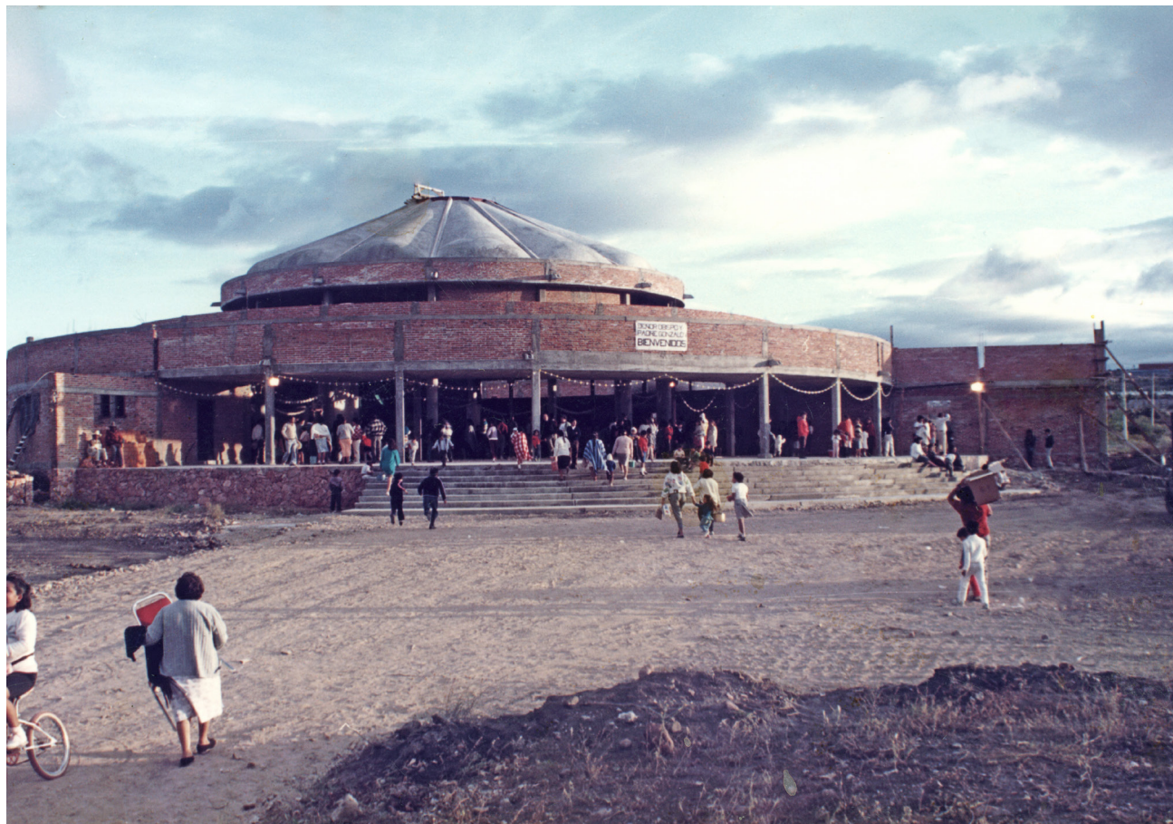
Parroquia de San José Obrero en construcción. José Velázquez Quintanar.
