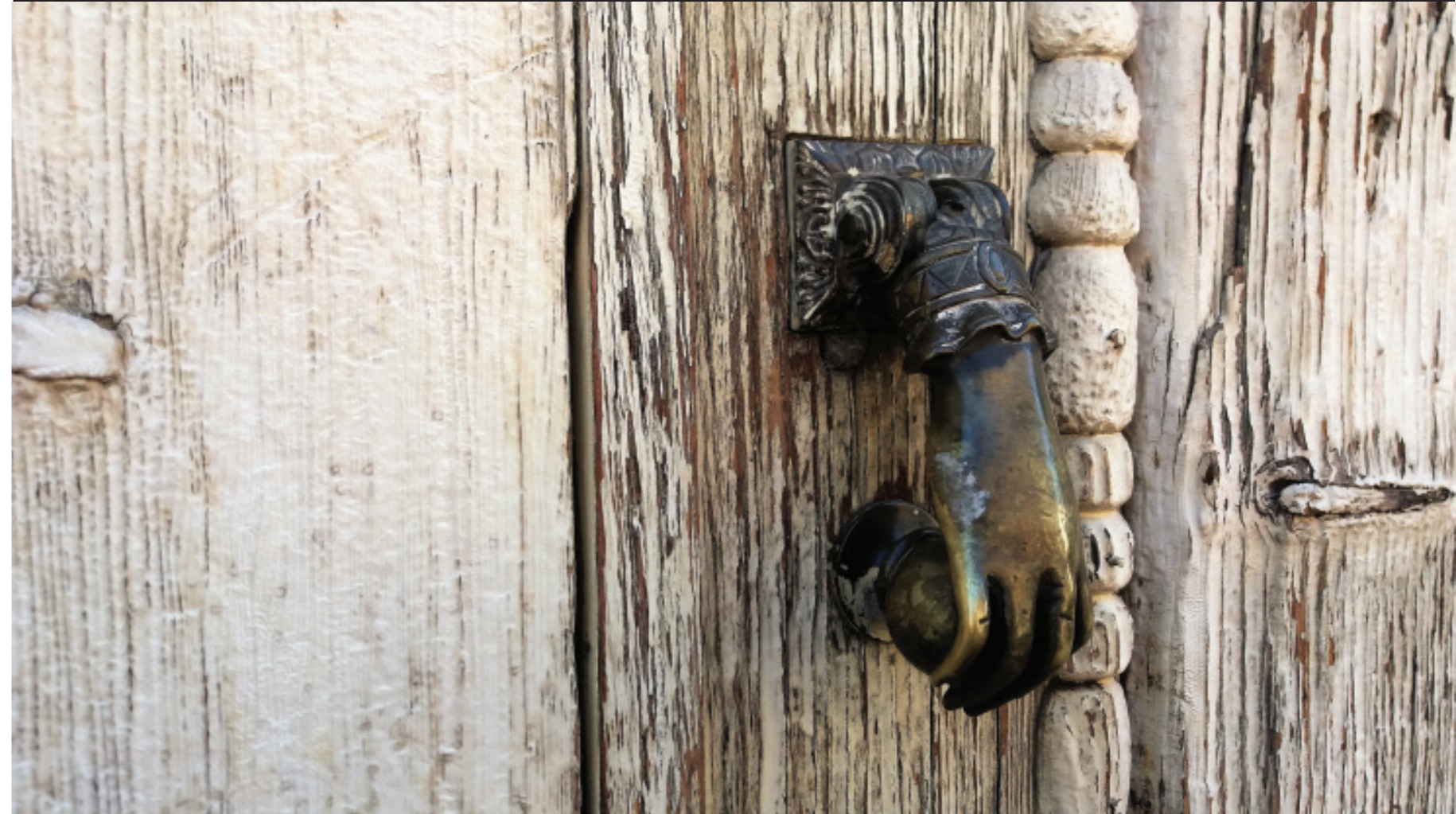
2 Aldaba en puerta. Detalle.
