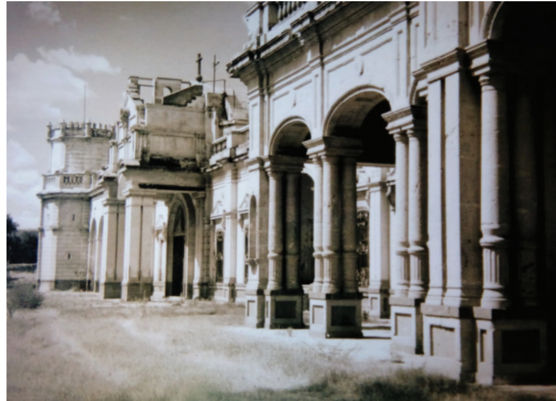
46 Hacienda La Llave. Vista parcial de la fachada, entrada a la capilla y torreón. Ca. 1955
