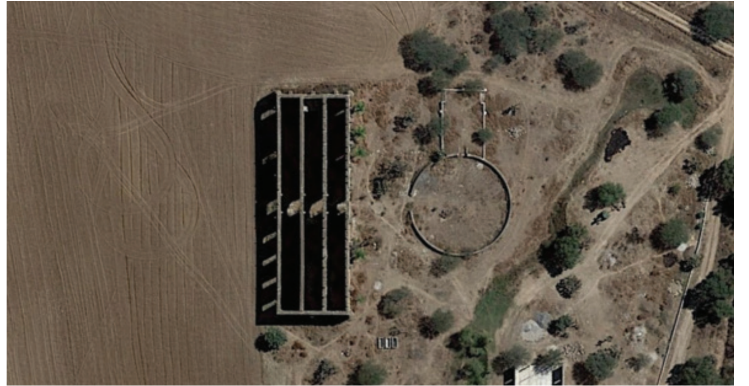
126 Troje-gavillero de la Hacienda San Nicolás. Vista aérea.
