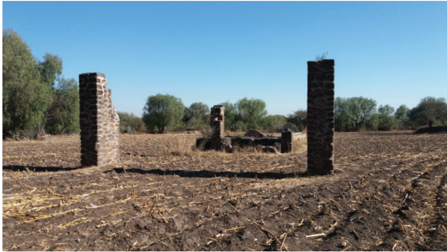
64 Ruinas del pozo y abrevaderos en la comunidad de Arcila.
