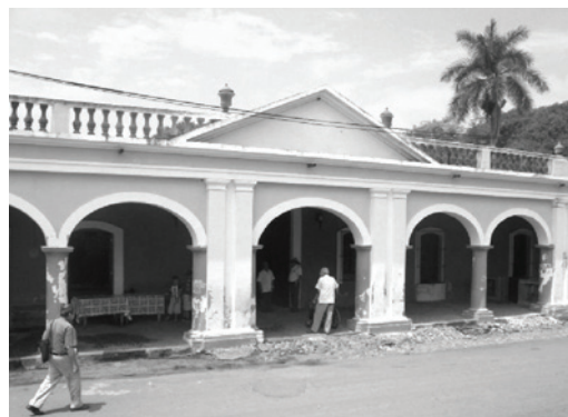
Ilustración 2 Aspecto actual de la fachada de la Ex-hacienda de Chiapa
