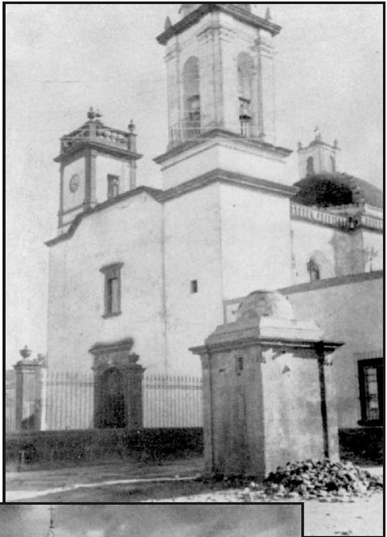
Fachada del Templo del Santuario y caja del agua
