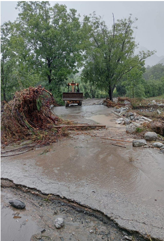
Equipo pesado libera las vías que comunican a Rayones con el resto de la entidad. Fuente: El autor.
